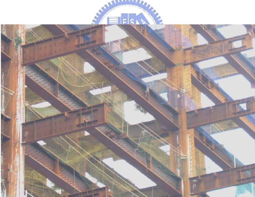
照片 1.2 臺北信義計畫區 SRC 群樓鋼梁開孔情形
