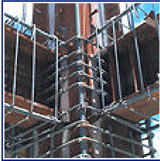
圖 5-25 SRC梁柱接頭箍工地照片
