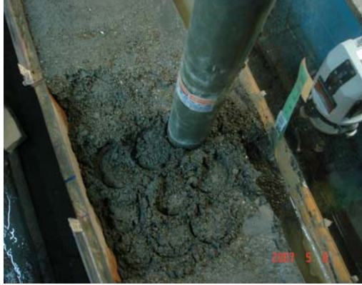
照片 3-5 土堤夯實
