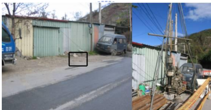
圖 3.6 X1 孔鑽探前與鑽孔施作情形
