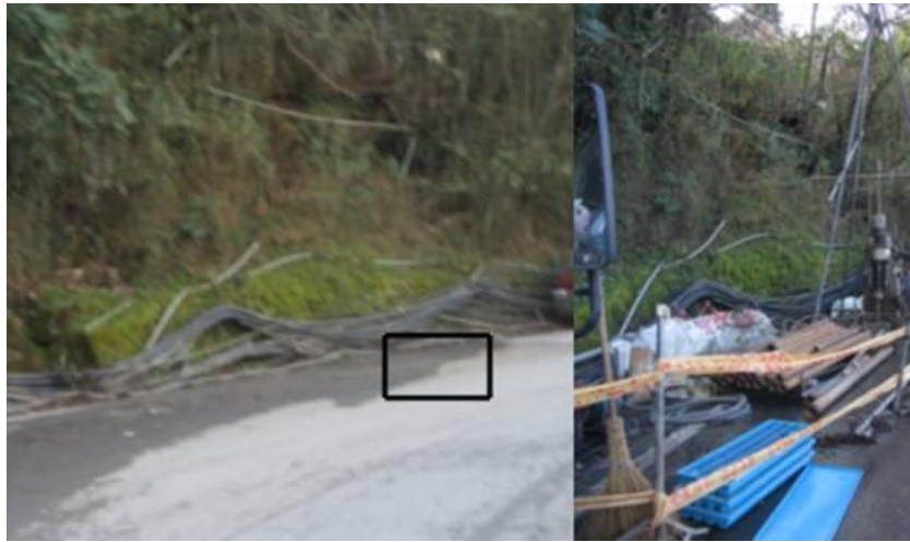
圖 3.8 X3 孔鑽探前與鑽孔施作情形
