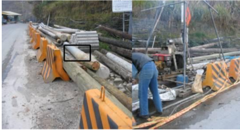
圖 3.7 X2 孔鑽探前與鑽孔施作情形
