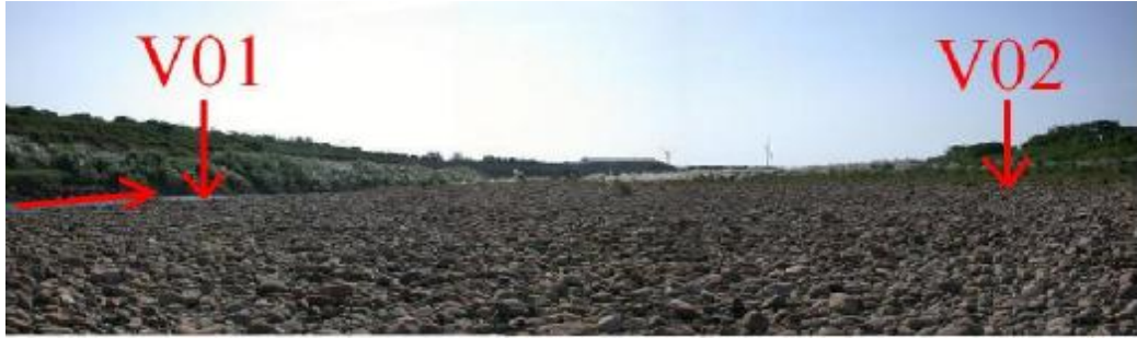
圖 4-3 橫斷面一現場照片與體積法施做位置
