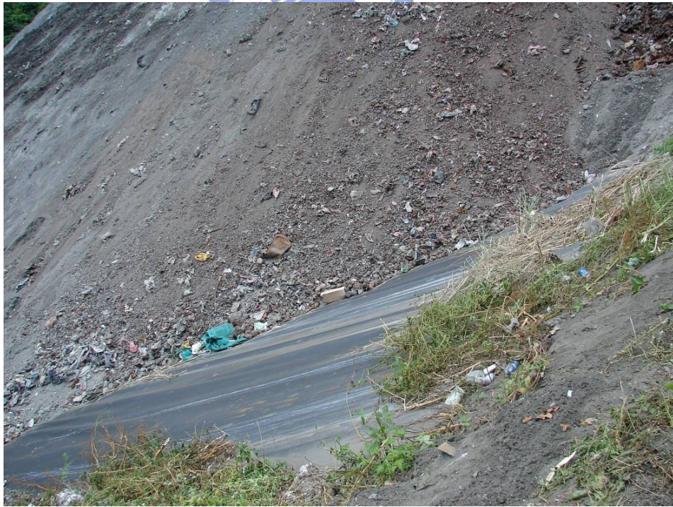
圖 2.3 灰渣與地工合成材直接接觸（單信瑜，2007）
