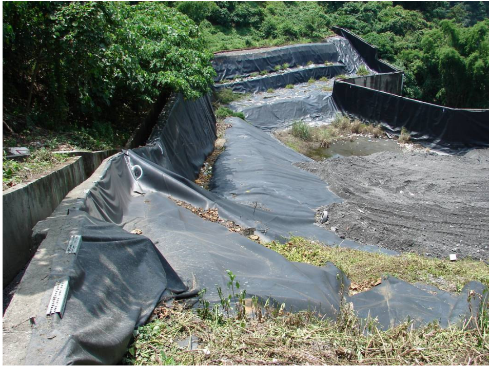
圖 2.4 地工合成材外露 (單信瑜, 2007)
