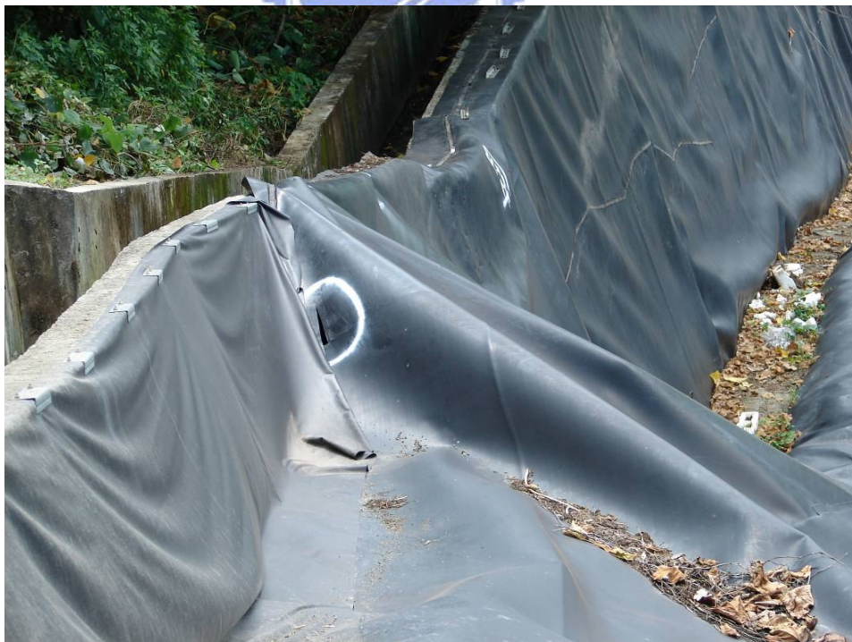
圖 2.5 地工合成材未能有效保護致使受破壞 (單信瑜, 2007)
