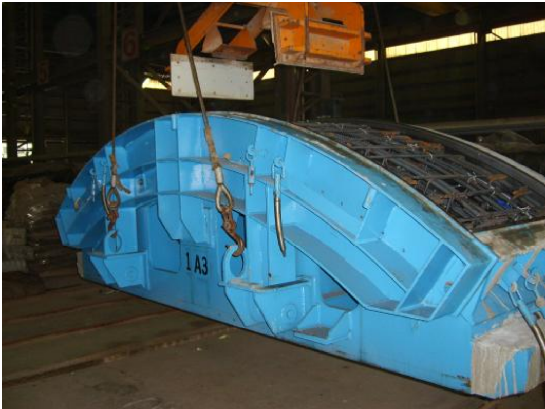
圖 4.4 鋼筋籠放入環片鋼模
