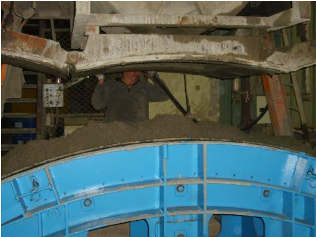
圖 4.6 混凝土澆置填滿環片鋼模
