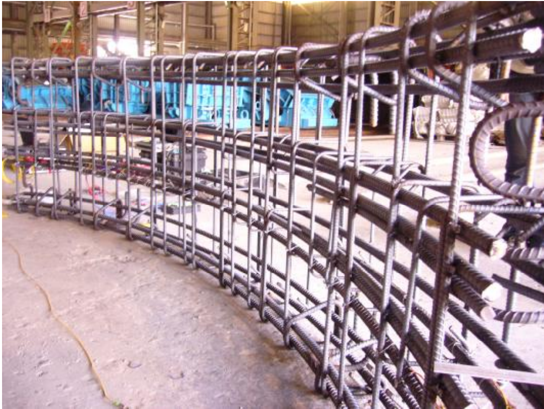
圖 4.1 鋼筋籠與光纖光柵鋼筋應變計
