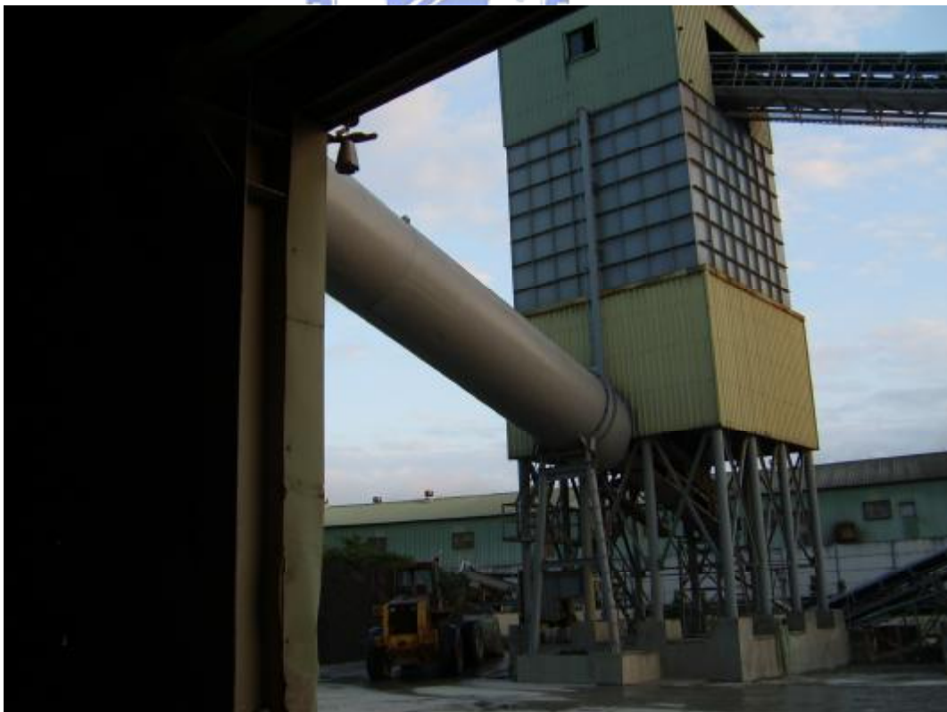
圖 4.5 混凝土由運輸管輸送至預鑄環片場
