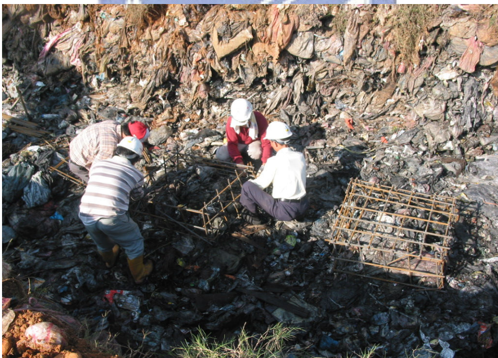
圖 3-13 試體修飾及紮筋
