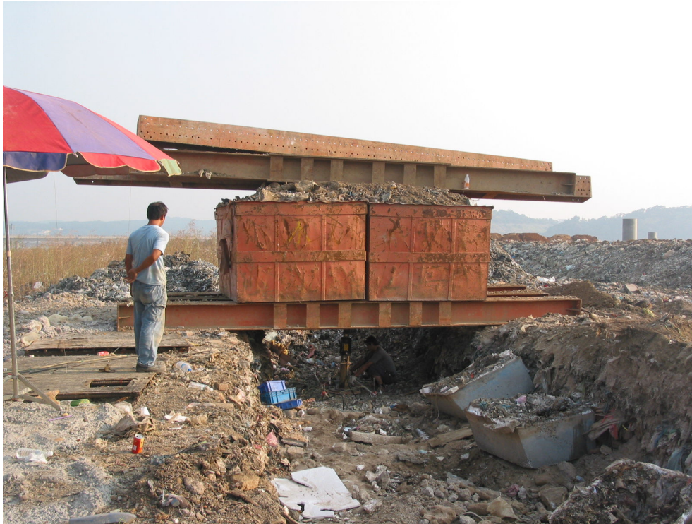
圖 3-17 架設載重台
