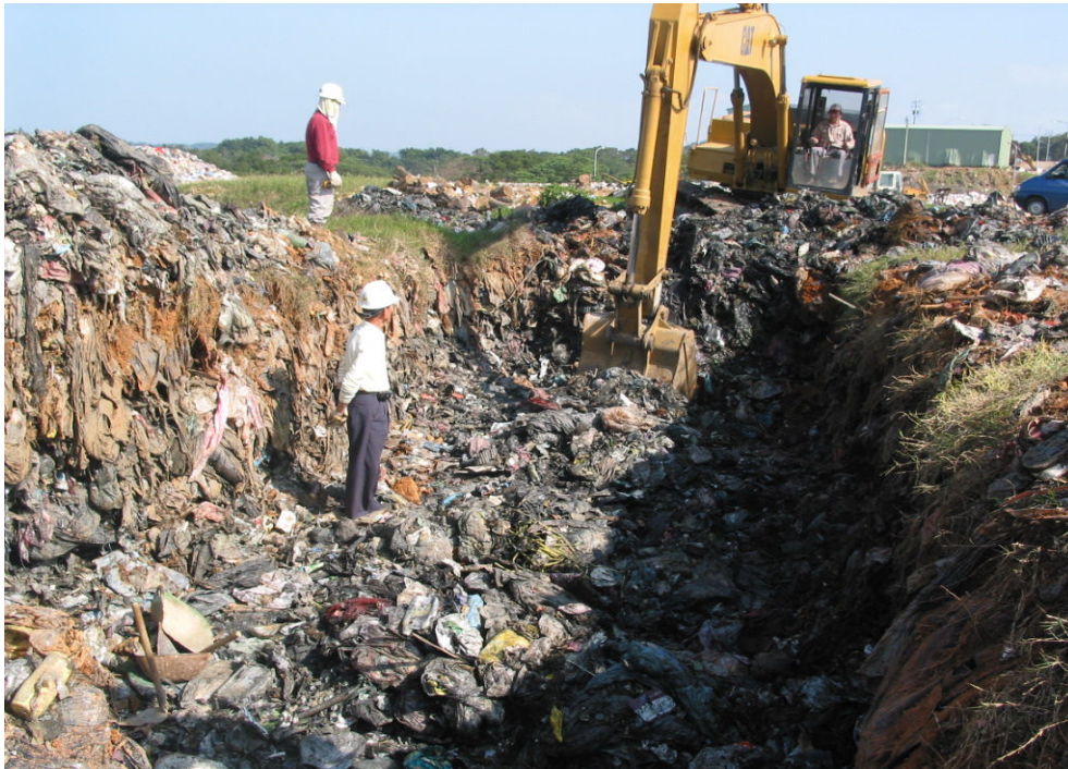
圖 3-12 試坑開挖
