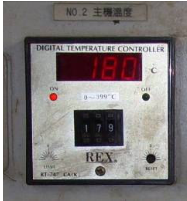
圖4.10 (b) 鉛粉主機內的溫度下降後再恢復正常作業
