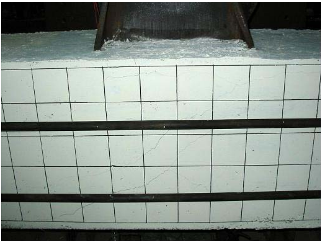
照片 4.2 試體 SRC1 之梁柱接頭區側面混凝土開裂最終發展情形
