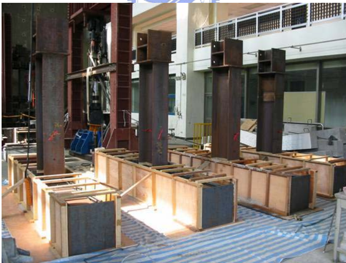
照片 3.2 試體模板實際組裝情形
