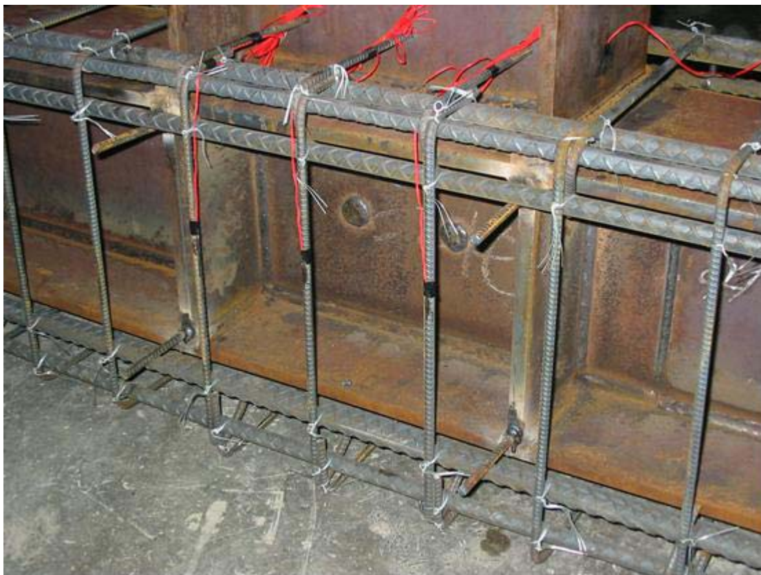
照片 3.1 梁柱接頭區圍束箍筋實際配置及疊合板銲接情形
