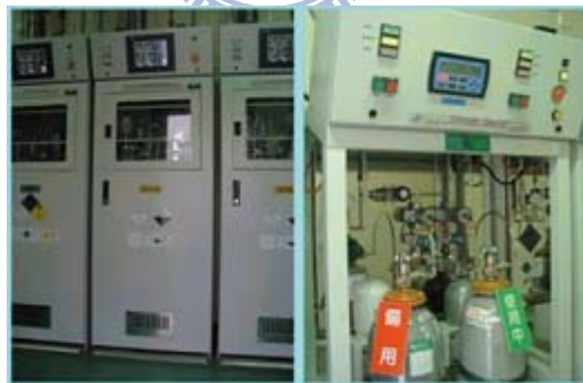
圖 2-9:氣瓶櫃和氣瓶架外觀圖
