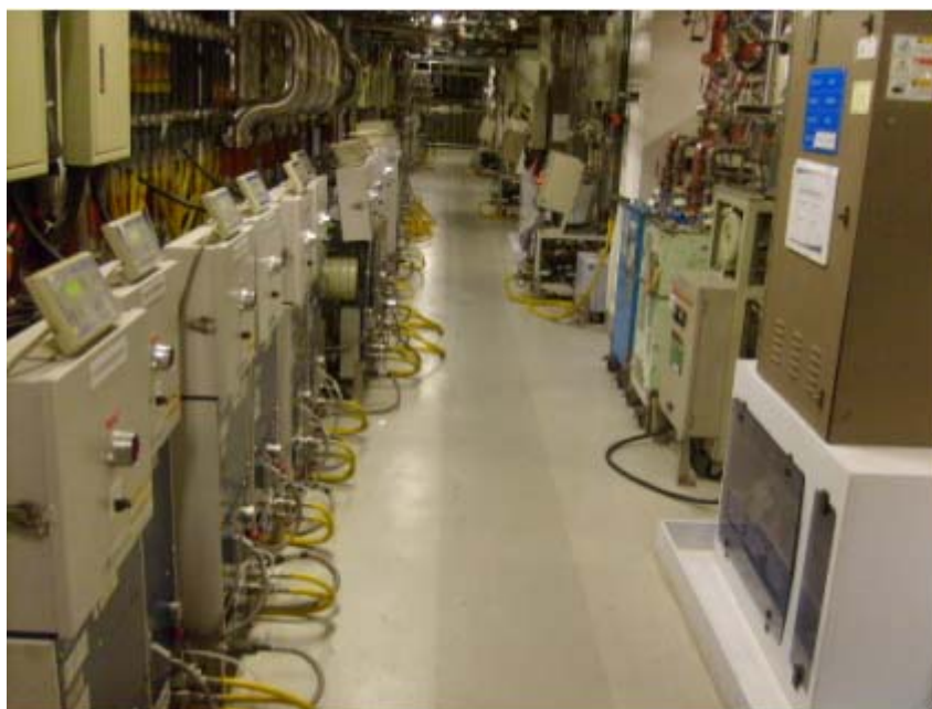
圖 3-2:CVD Utility Area 現場環境一隅
