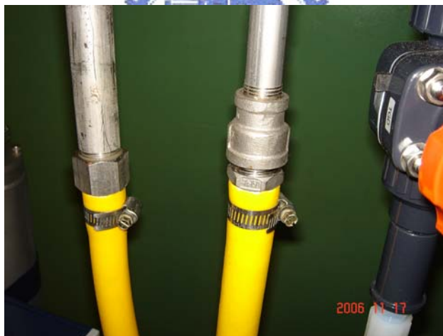
圖 64 製程管路的防震軟管設計照片
