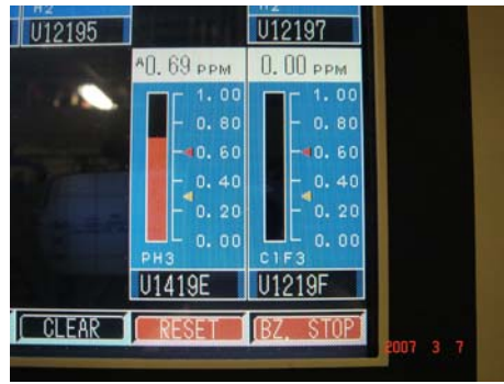
圖 65 特殊氣體洩漏氣體探測系統
