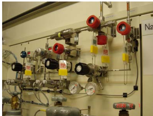
圖 58 氣體管路閥體防愚操作防護照片
