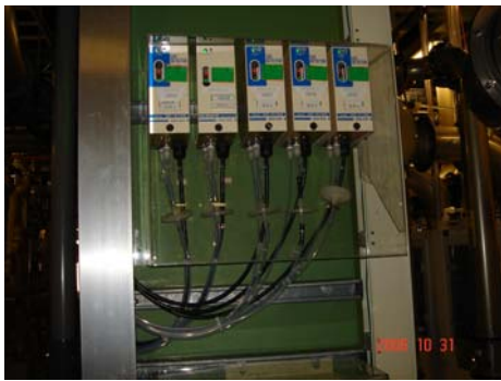
圖 65 特殊氣體洩漏氣體探測系統
