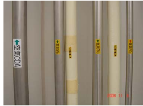
圖 61 壓力表指示範圍與反應氣體管路流向標示照片
