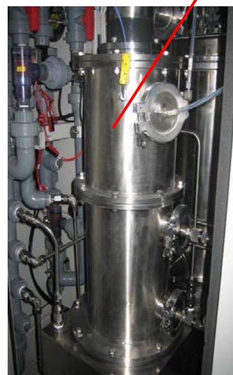
圖2-15電熱水洗式- ECS2250 電熱腔室及洗滌塔外觀圖
