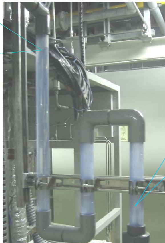
圖 4-10 Acid Exhaust 積水問題及水封改善照片
