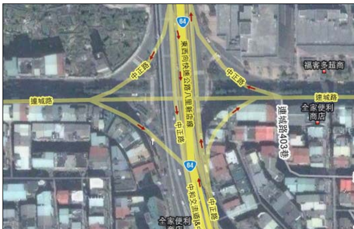
圖 1-1 中和中正路連城路路口空照圖
