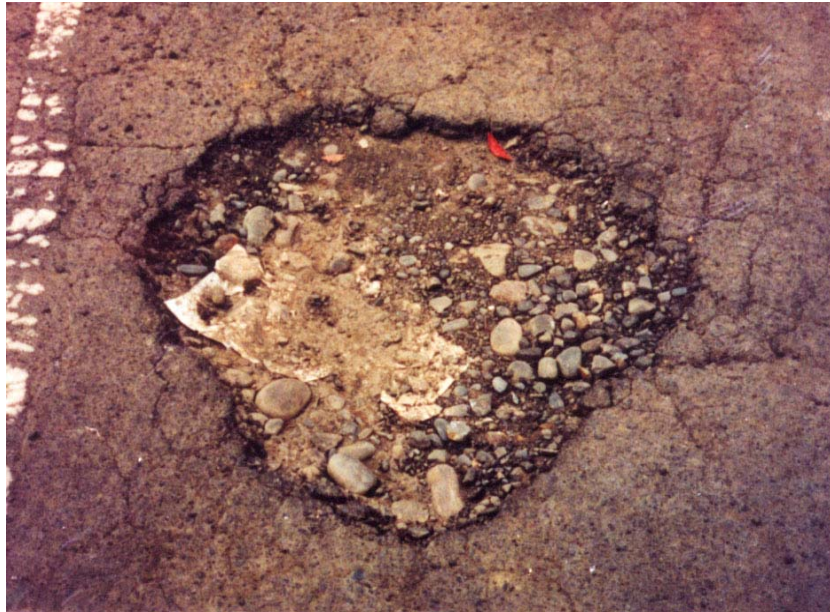
圖 2-10 路面坑洞
