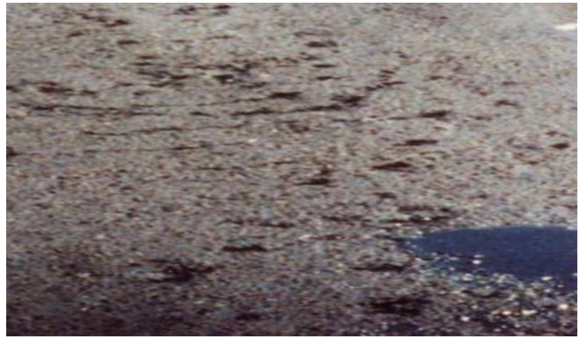
圖 2-14 路面滑溜裂縫
