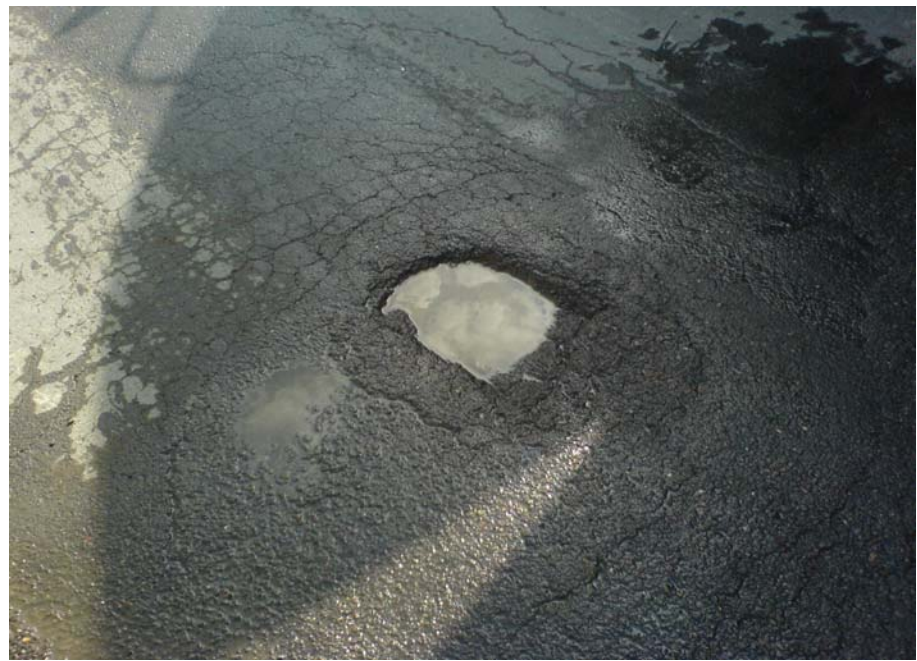
圖 2-24 積水造成路面浸蝕（二）
