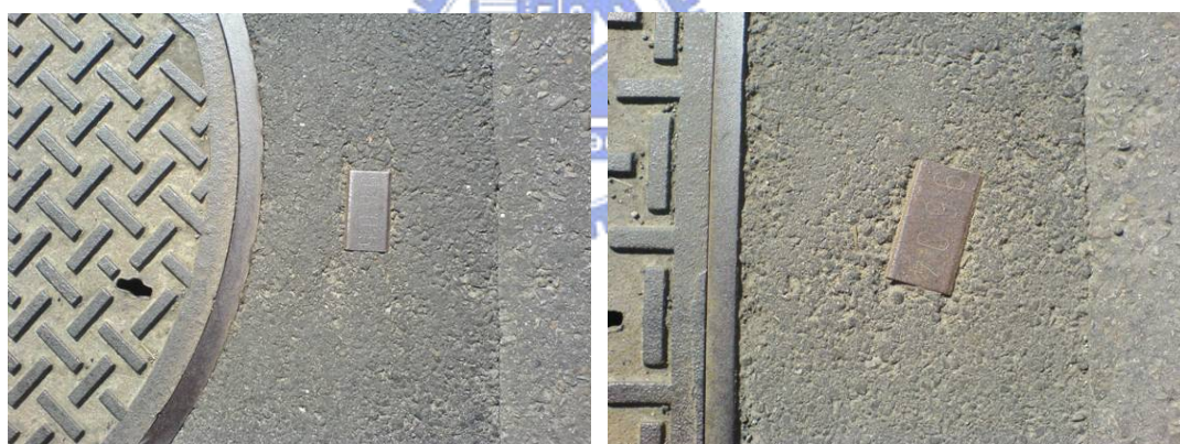
圖 4-16 人(手)孔蓋進行編碼並於孔蓋烙碼有助於尋找
