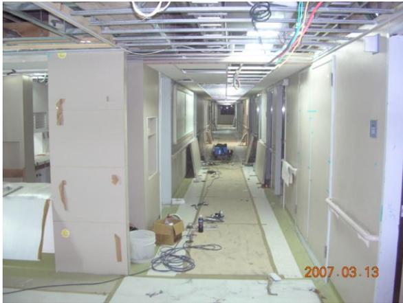
圖2-9 平頂輕鋼架構造
