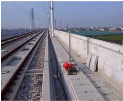
GPS Survey Mark(Interval 2km)
