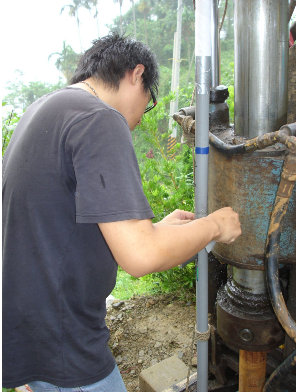
圖 4.6 NCTU-02 光纖光柵水壓計裝設概況圖
