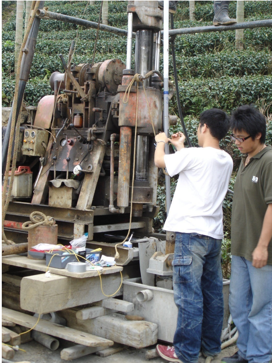
圖 4.7 NCTU-03 光纖光柵水壓計裝設概況圖
