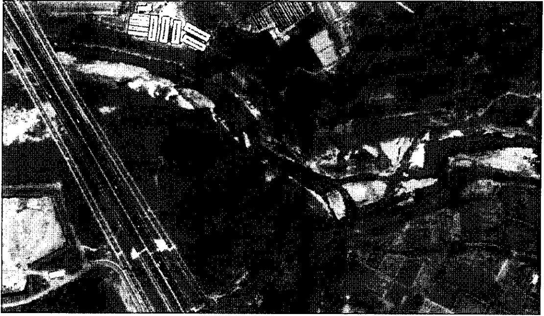
照片 21 朴子溪高速公路橋(91 年)
