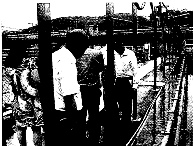
寶山給水廠一期沉澱池現場會勘
