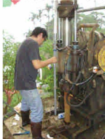
(b)FBG 水壓計置入鑽孔
