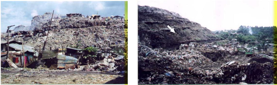
圖 1-5 菲律賓馬尼拉 Payatas 掩埋場崩塌狀況
