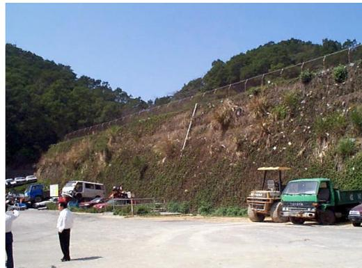
圖 1-4 以加勁擋土牆作為圍阻體之地上型掩埋場
