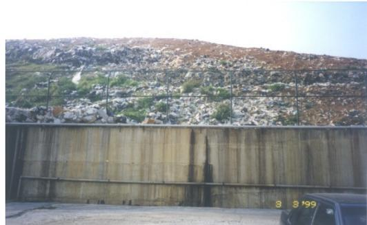
圖 1-3 以鋼筋混凝土擋土牆作為圍阻體之地上型掩埋場
