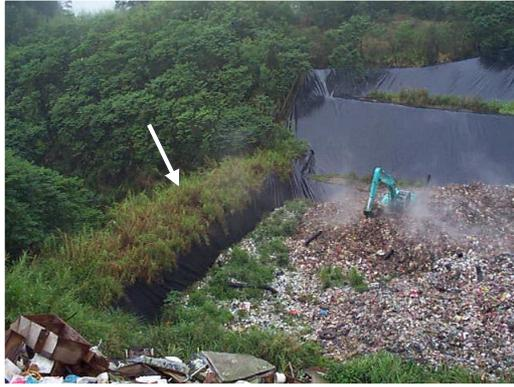
圖 1-2 以加勁擋土牆阻斷山谷興建之掩埋場 (圖中箭頭所指處為加勁擋土牆)
