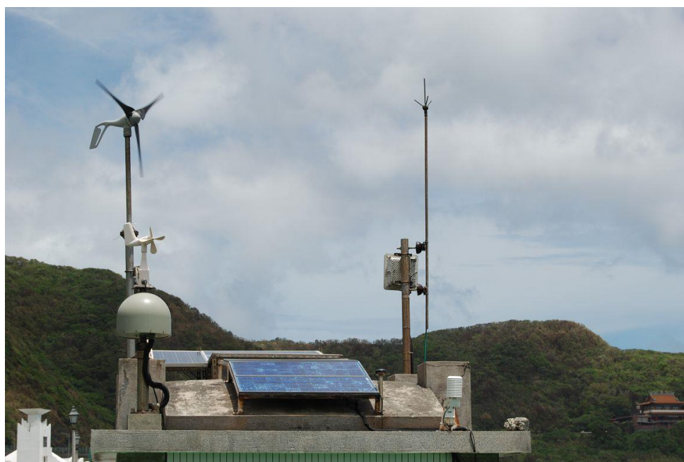
圖七：觀測屋頂上設施情形
