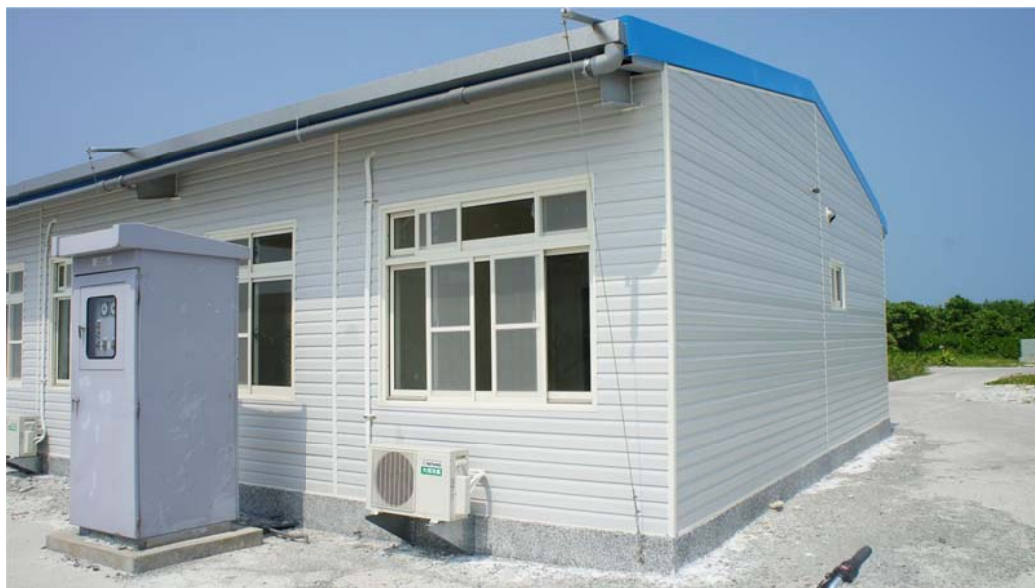
圖 4-2、安檢站工程現況
