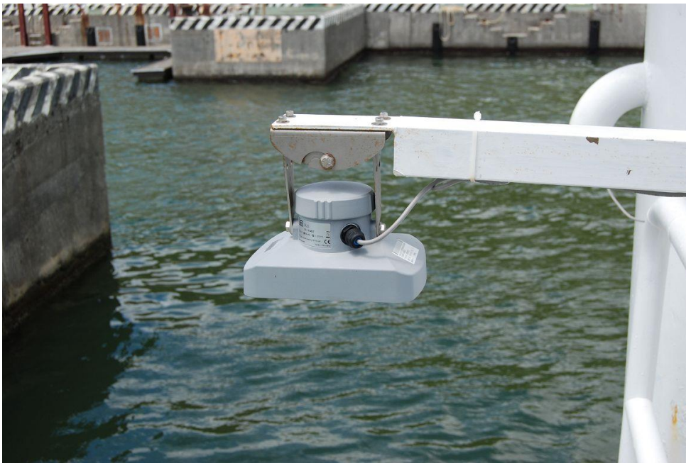
圖五：潮位觀測感測設施(雷達式)
