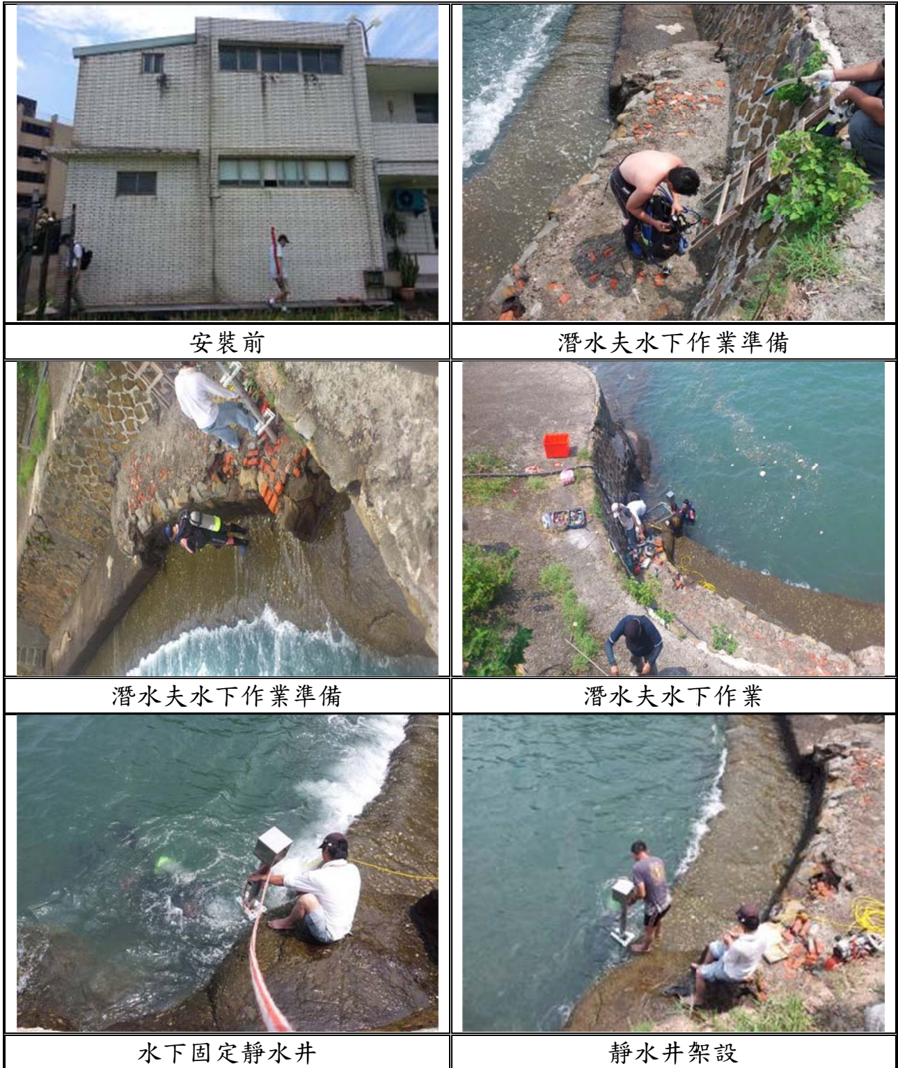
圖 6-15、基隆新設潮位站臨時性潮位站施工照片
