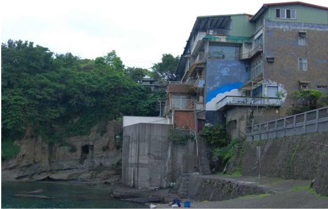
圖八、儀器箱掛放擋土牆
