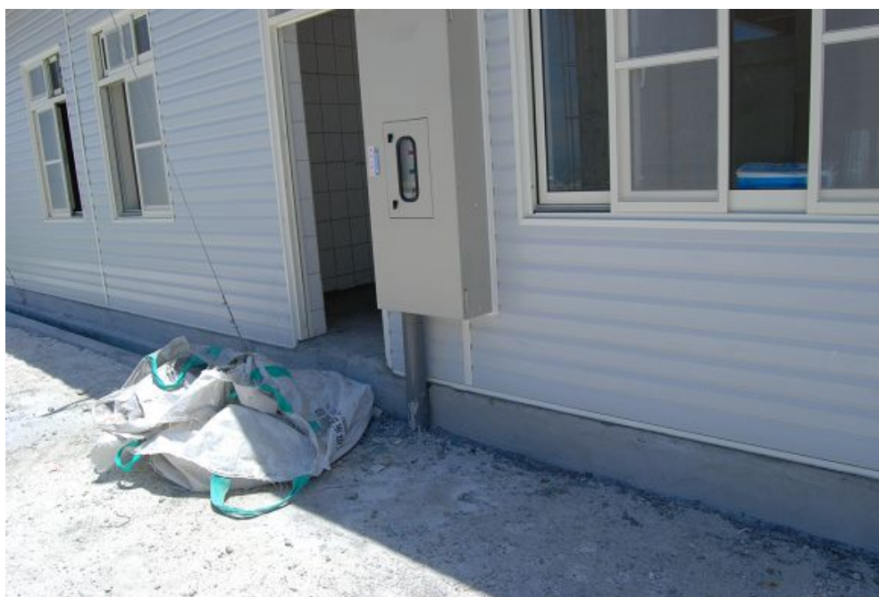
圖四:新建房舍面海向門
