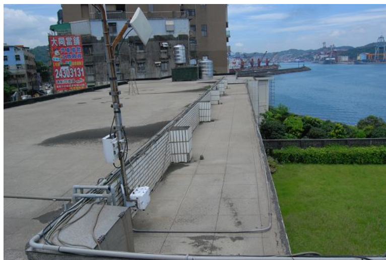
圖九、東岸會議室屋頂女兒牆
