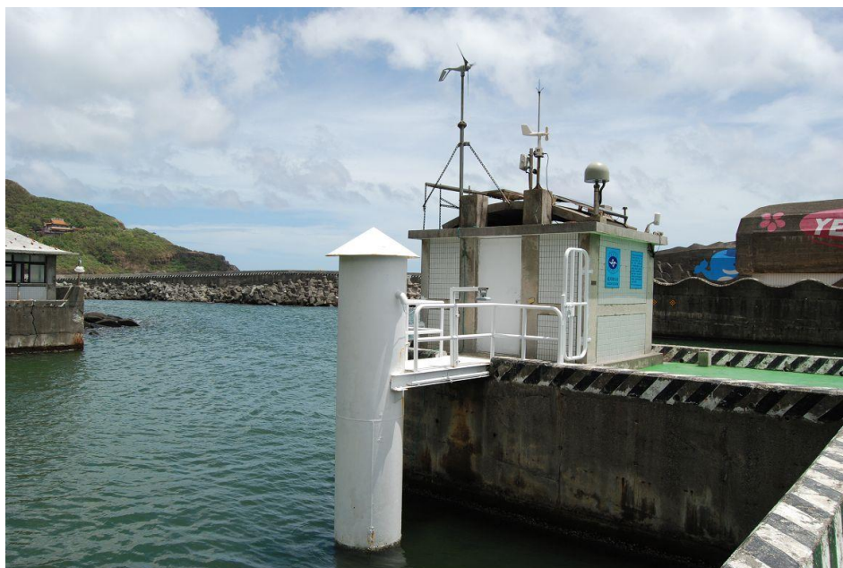
圖三：龍洞潮位站觀測屋與靜水井
