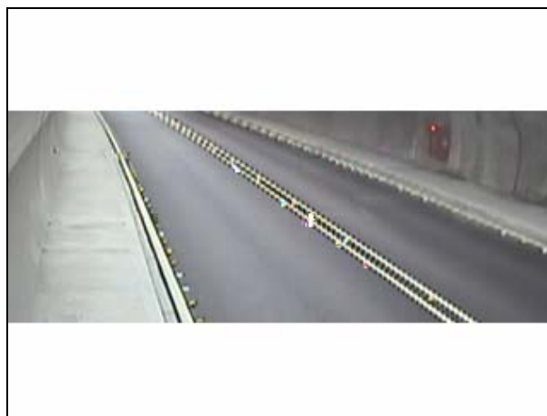
圖 5.4.1-4 雪山隧道編號第 2073 支 CCTV 攝影機收斂的背景影像
