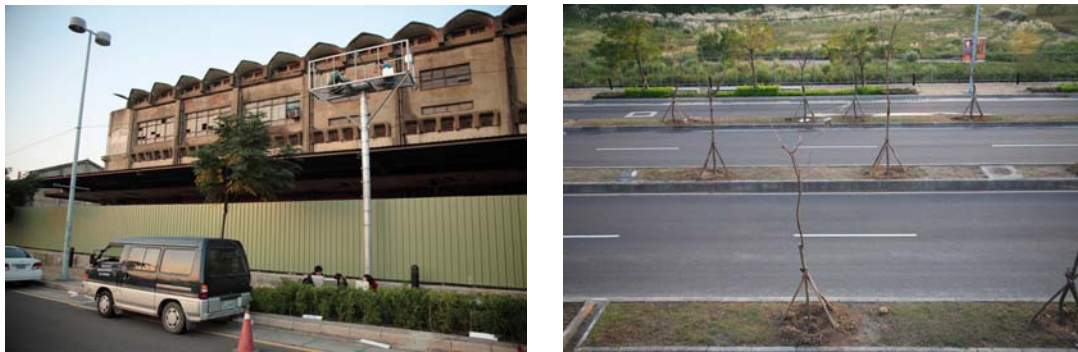
圖 4.1-7 實測現場概況
