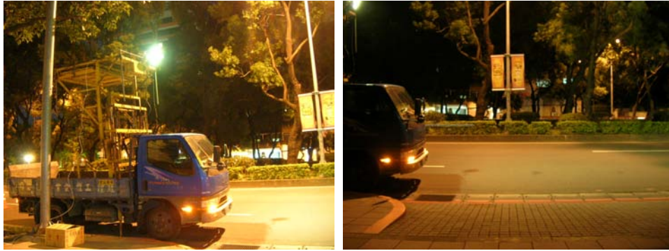
圖 2.3-13 運研所前進行照明設備架設
