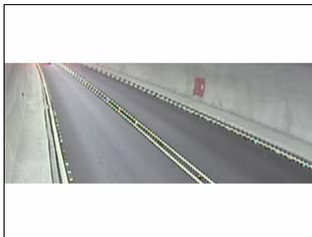
圖 5.4.1-6 雪山隧道編號第 2069 支 CCTV 攝影機收斂的背景影像
