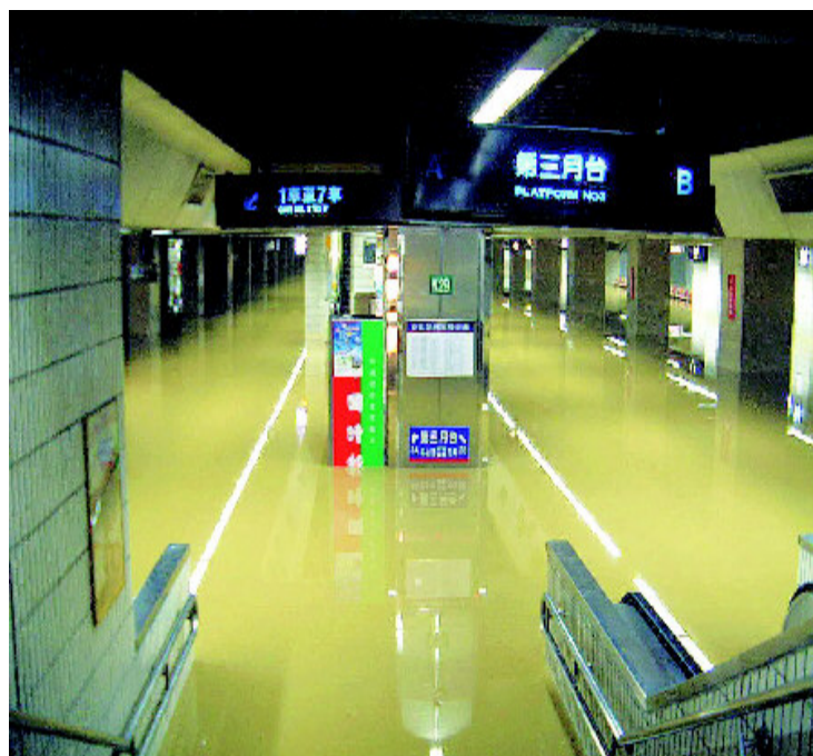
圖 3.2 納莉颱風水災臺鐵臺北車站淹水情形 [50]
