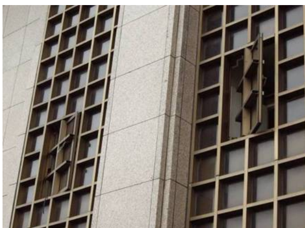
G+2層以上緊急進口之寬度不足
