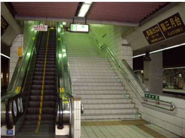
直通樓梯貫穿樓板未設置垂直防火區劃
