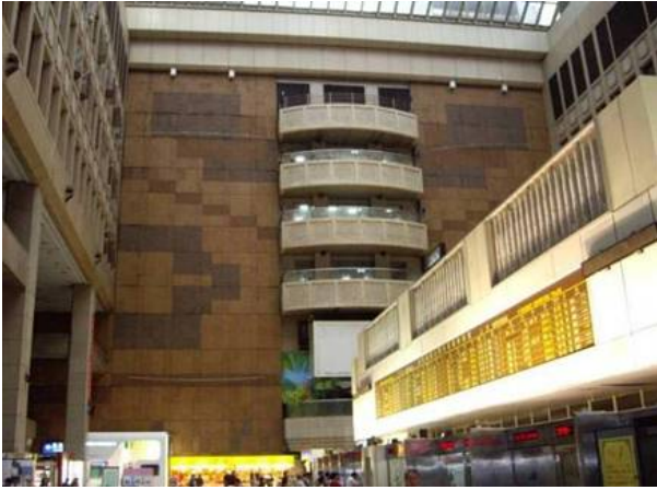
樓地板 > 1500m 2 無法設置平面防火區劃
