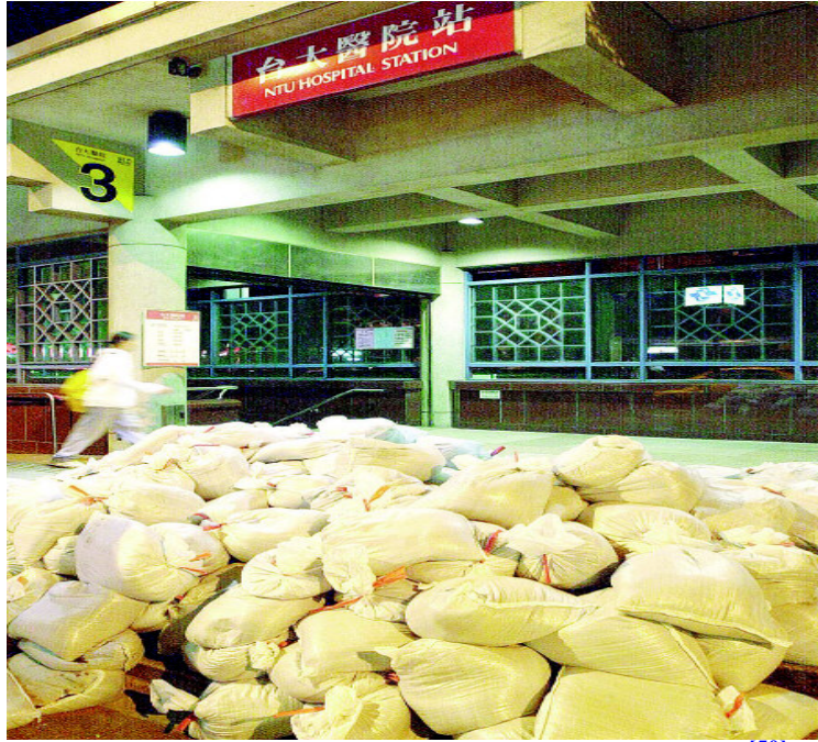
圖 3.3 納莉颱風水災臺北捷運車站堆沙包情形 [50]
