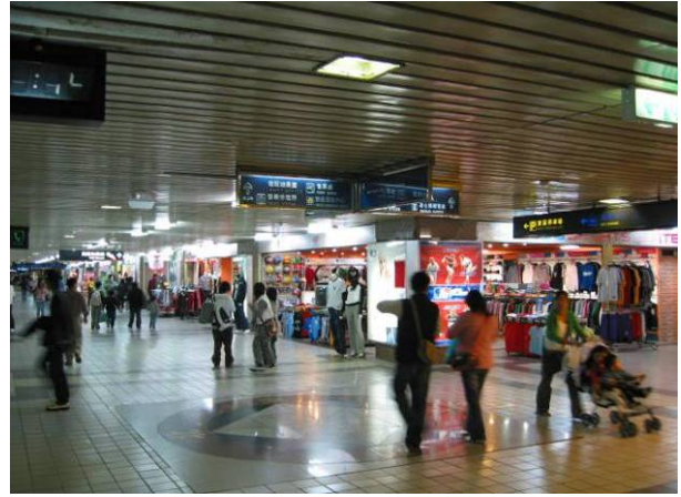
B1穿堂層公共空間未設置撒水頭防護
