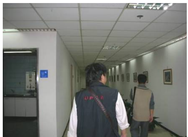
G+3層辦公區域未設置火警探測器
