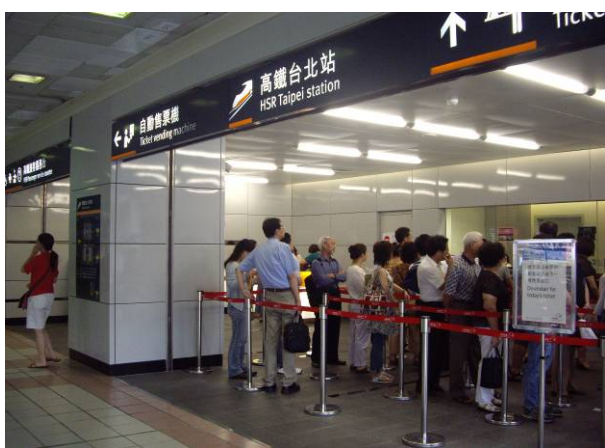
G+1層高鐵非公共區防火區劃未設置
