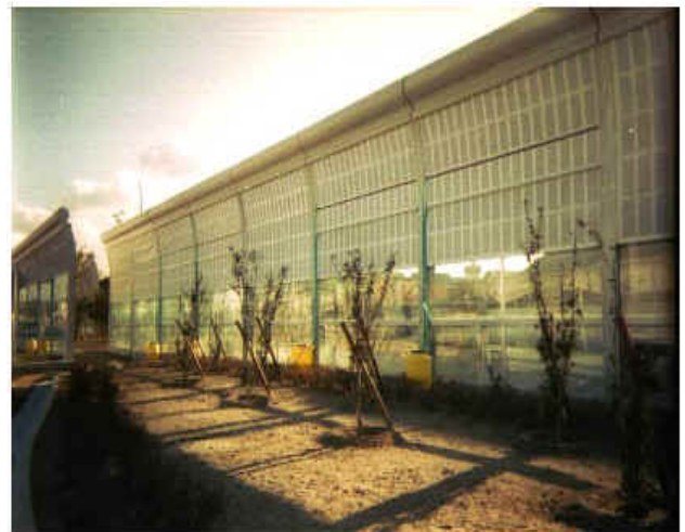
圖 3.8 名古屋市光觸媒隔音牆實景
