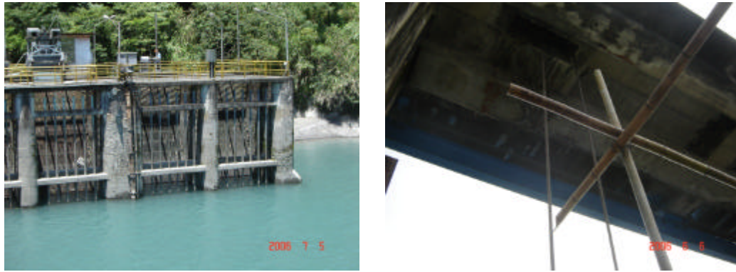
圖 5.8 混凝土表面有風化及白華的現象
