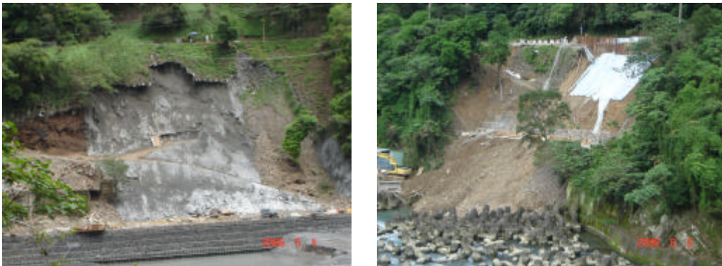
圖 5.6 庫區邊坡滑落
