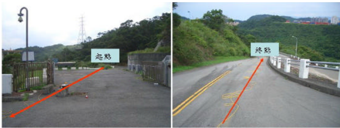
圖 4.35 新山水庫測線 E (左山脊通達道路) 施測情形
