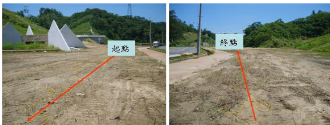
圖 4.44 寶二水庫壩基測線施測情形
