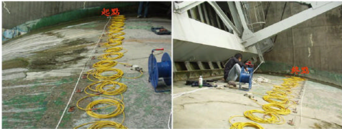
圖 4.56 石岡壩溢洪道 9 號閘門施測情形
