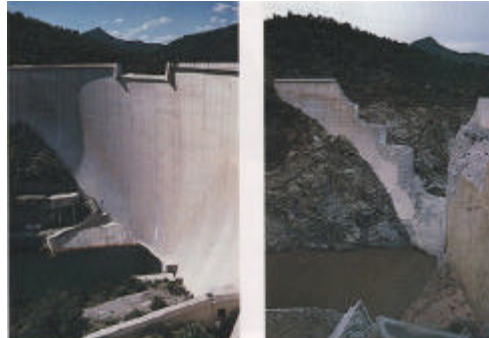
圖 5.5 Malpasset 水庫拱壩破壞照片
