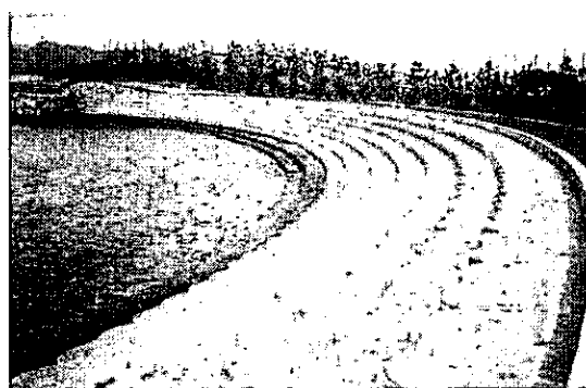
圖 9.5 台階式--階段式海堤
