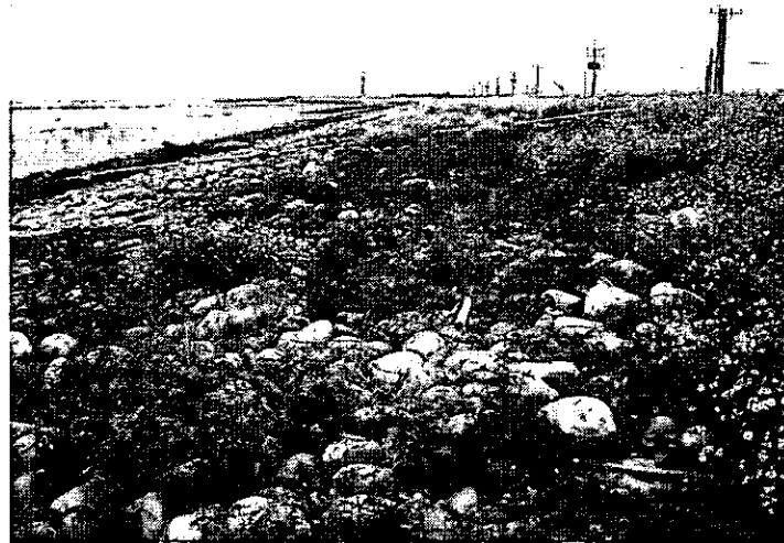
圖 2.10 永興緩坡式綠化海堤
