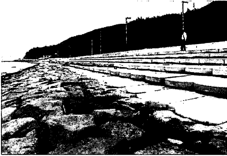
圖 9.10 斜面與台階混合式緩坡海堤
