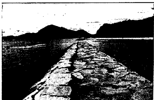
圖 9.2 斜面式--陡坡斜面式海堤
