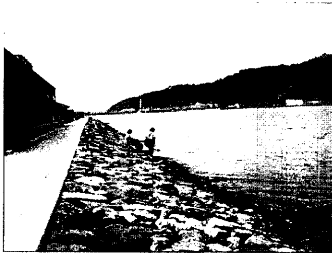
圖 9.13 岩塊拋石緩坡海堤
