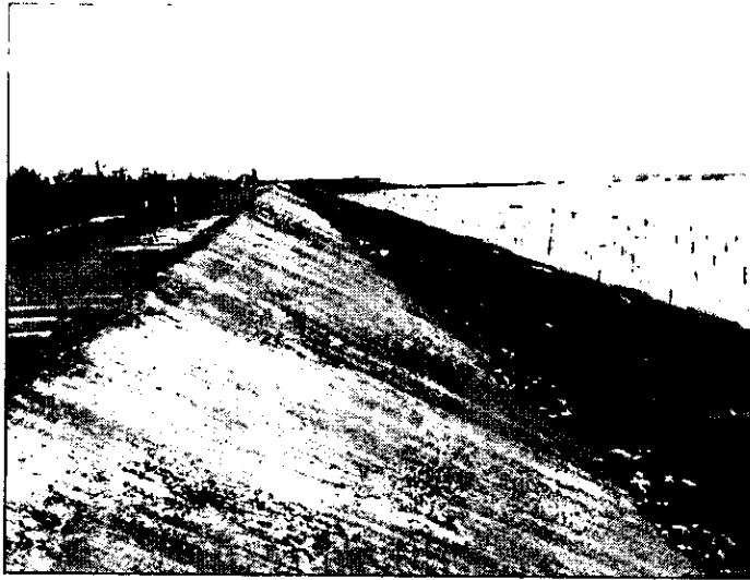
圖 2.12 芳苑海堤混凝土坡面
