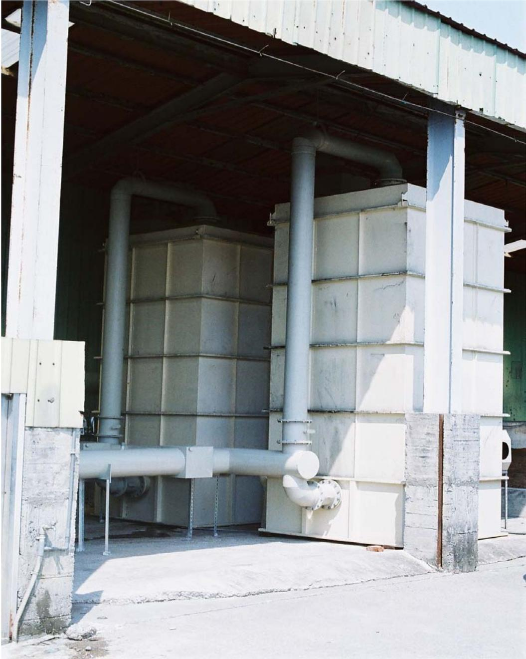
圖二 實場大型生物除臭系統設備圖
