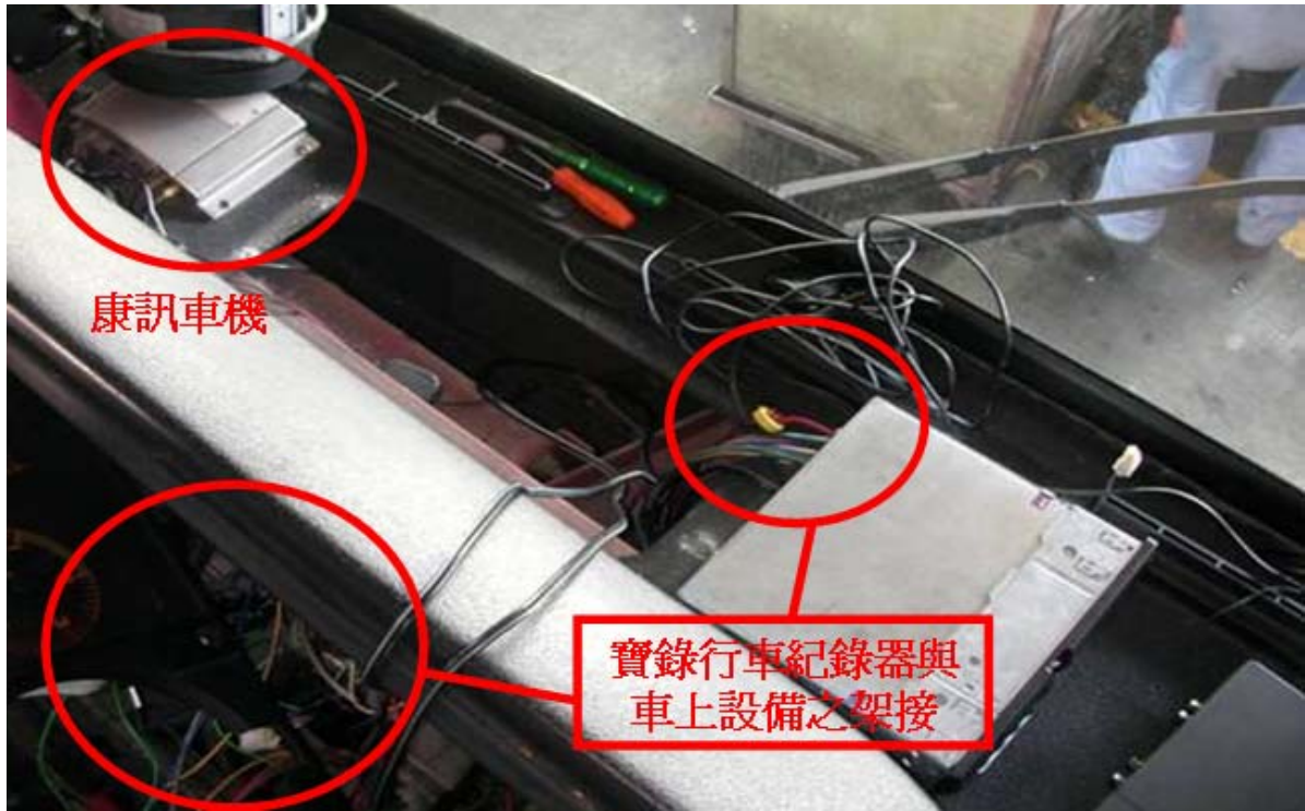
圖 6.4 車機安裝(二): 儀表板後方線路連接
