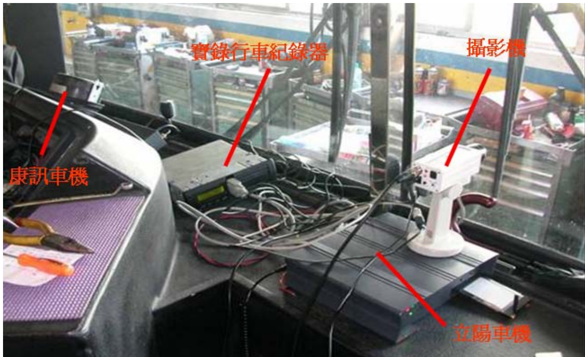
圖 6.7 車機安裝 (五): 整體串接完成
