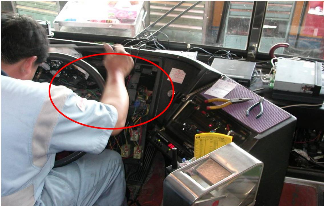
圖 6.3 車機安裝（一）：儀表板拆卸
