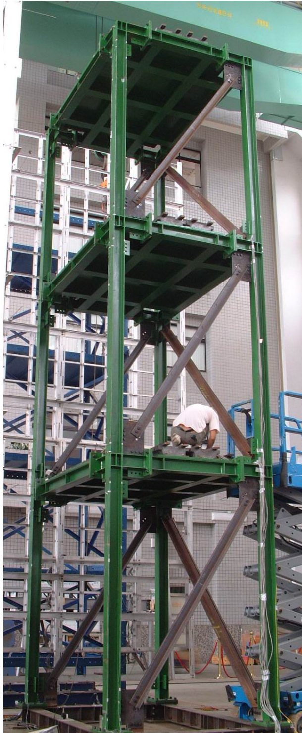
圖 5.2：國家地震工程研究中心之鋼構架
