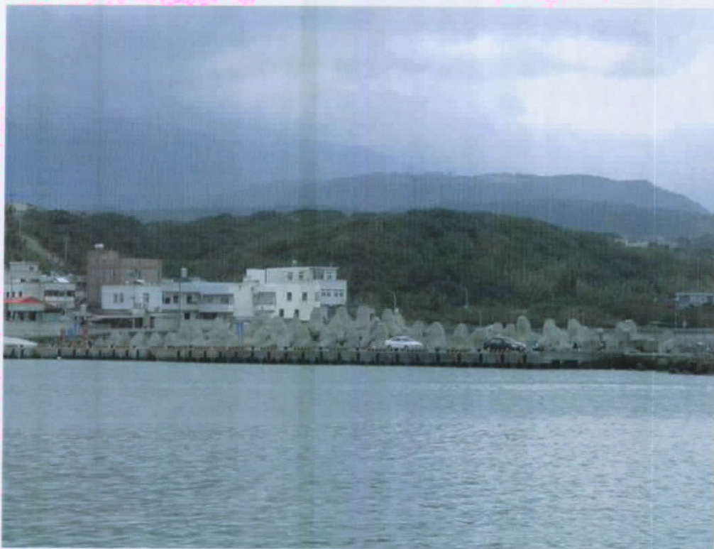
照片 5-15 【12】南防波堤—由北防波堤上之視域 (1)
