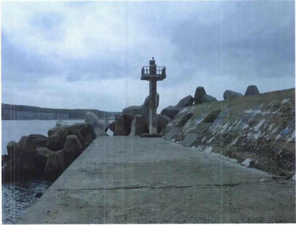
照片 5-4 【1】北防波堤向海面—堤面上
