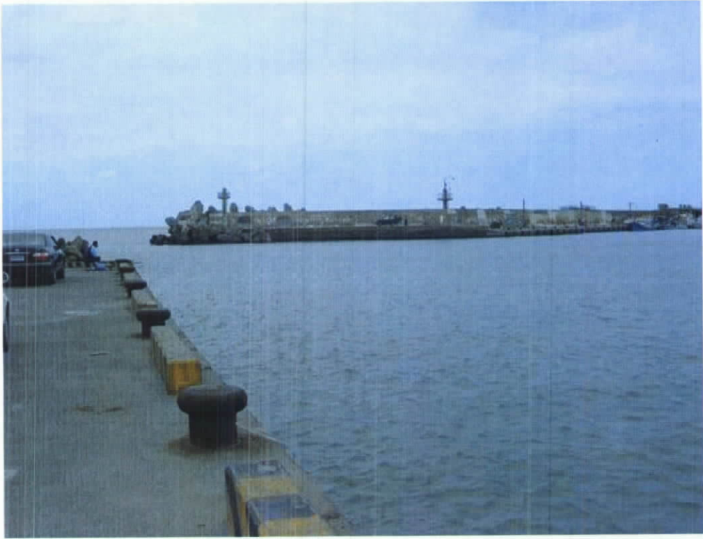
照片 5-20 【17】碼頭上之設施物—車擋及繫船柱
