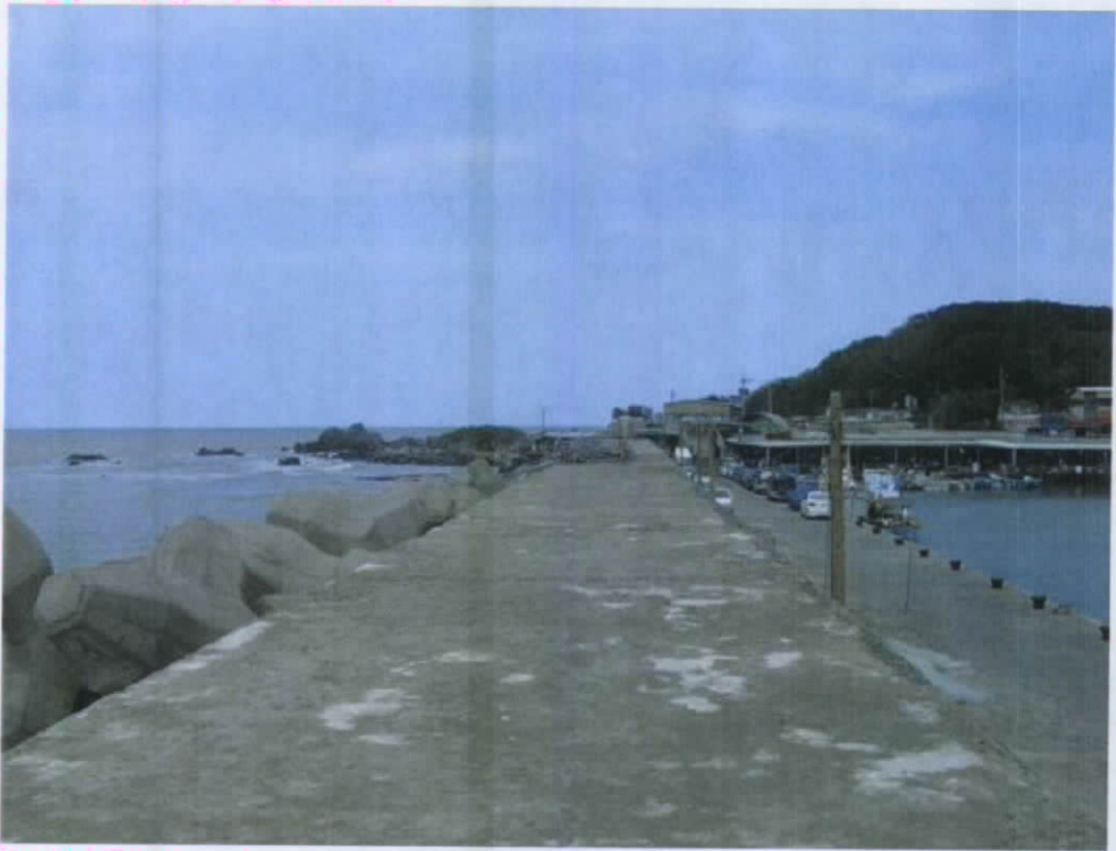
照片 5-7 【4】北防波堤向陸面--胸牆上
