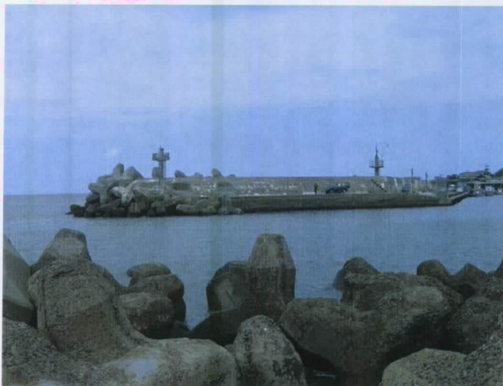
照片 5-14 【11】南防波堤消波塊—正面
