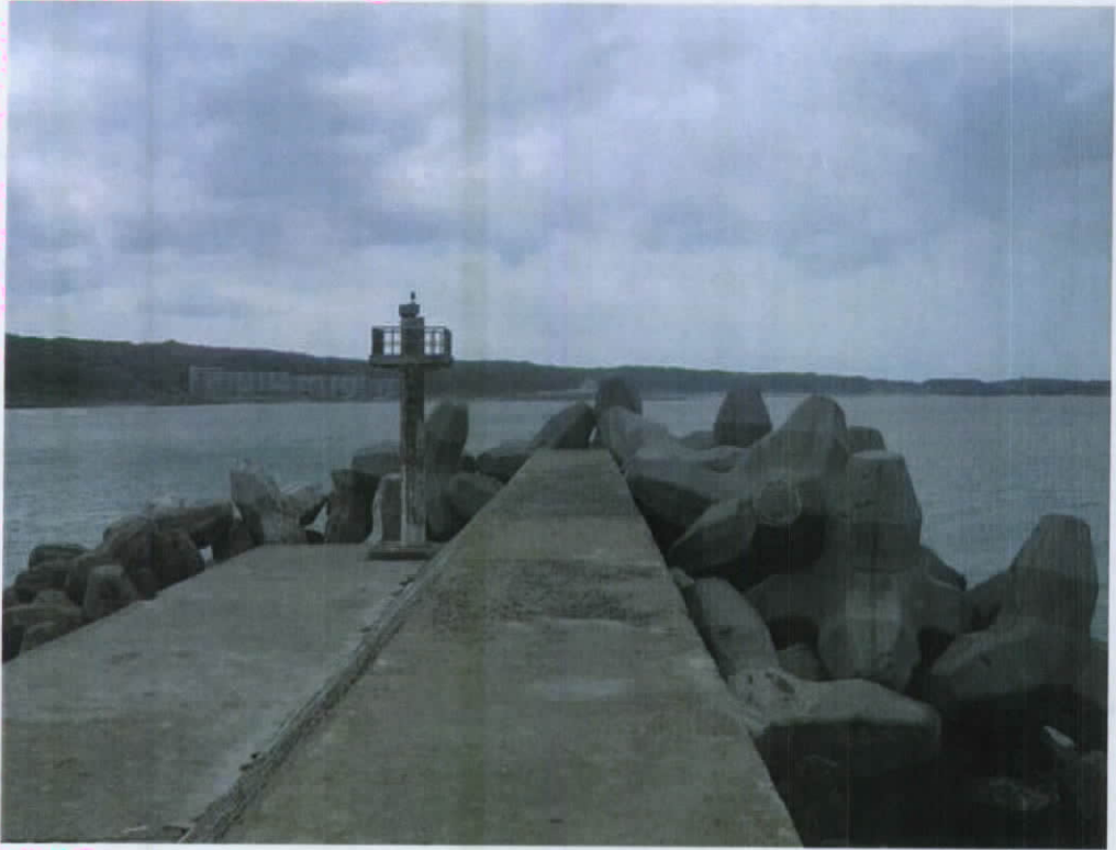
照片 5-6 【3】北防波堤向海面--胸牆上
