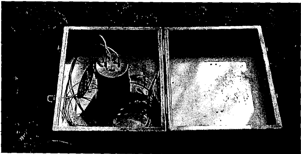
圖 3.19(e) 光纖光柵應變管安裝完成
