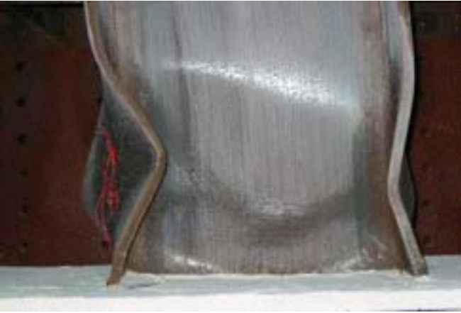
照片四 試體 SRC1 之鋼梁塑性變形情形
