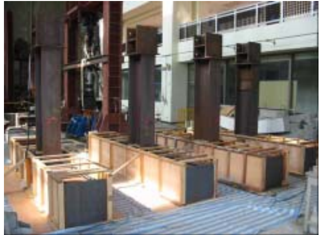
照片二 試體灌漿前模板組立情形
