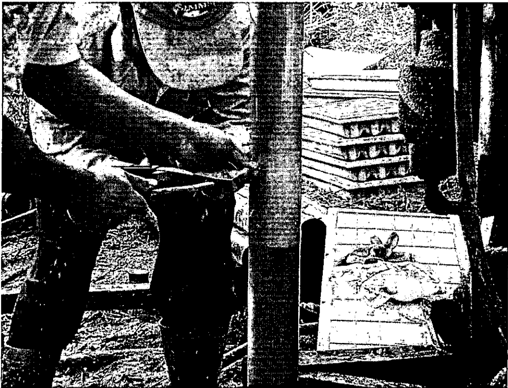
圖 4.6 傾斜管安裝情形
