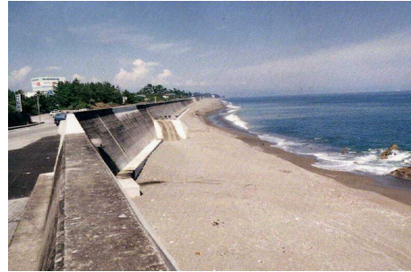
照片 1 傳統海堤
