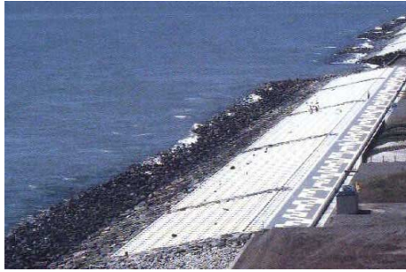
照片 5 緩坡式親水海堤
