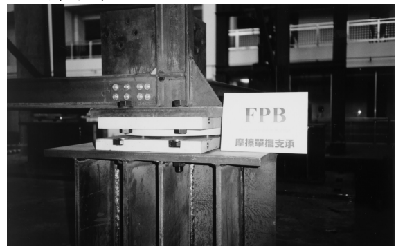
圖 8 摩擦單擺支承安裝位置近觀
