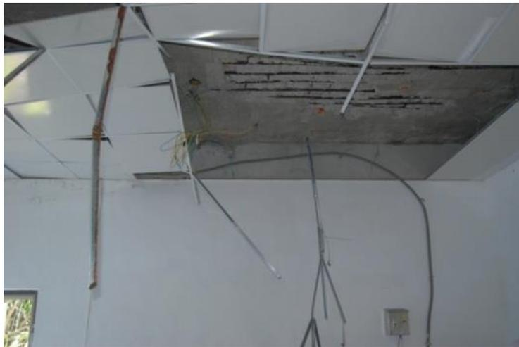
照片 2-3 建築物天花板漏水及鋼架鏽蝕情形(7/19/2012)
