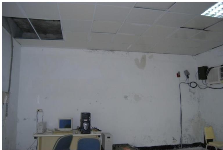
照片 2-1 建築物天花板混凝土剝落情形(6/5/2012)
