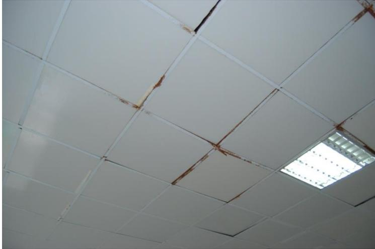
照片 2-2 建築物天花板漏水及鋼架鏽蝕情形(6/5/2012)
