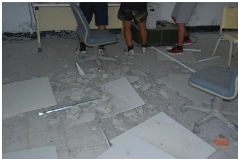
照片 2-4 混凝土剝落情形(7/19/2012)
