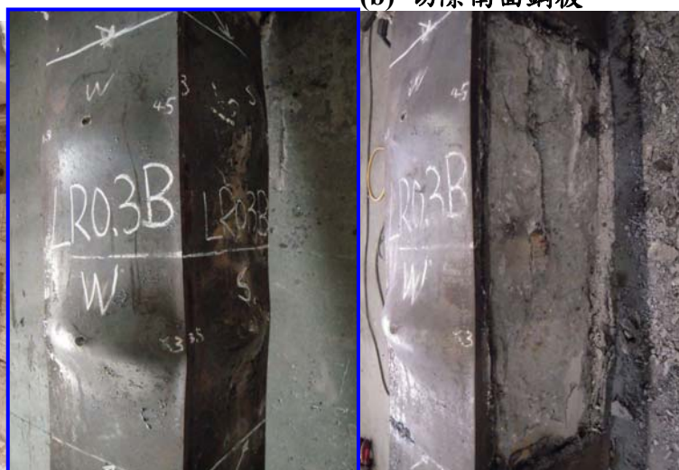
(b) 切除南面鋼板
