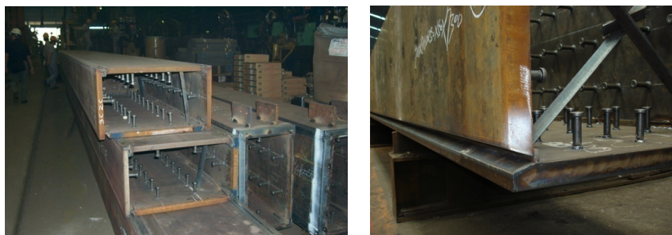
圖 1-3 內灌混凝土箱型柱
