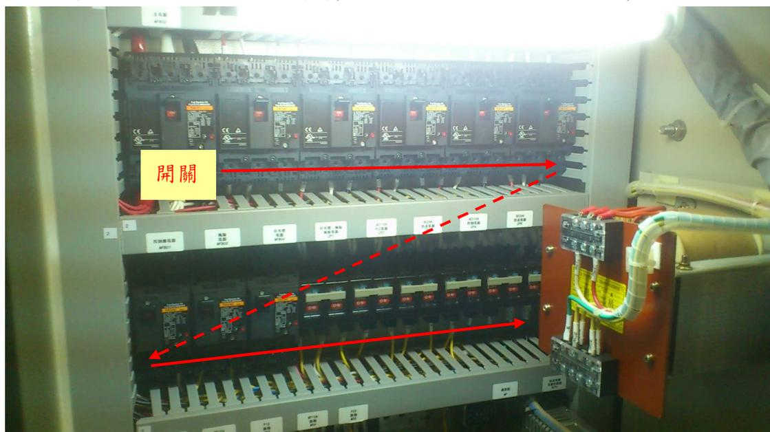
3.打開電源及 PLC 主控盤 2(混凝劑儲槽左邊，靠近沉澱槽，如下圖)
