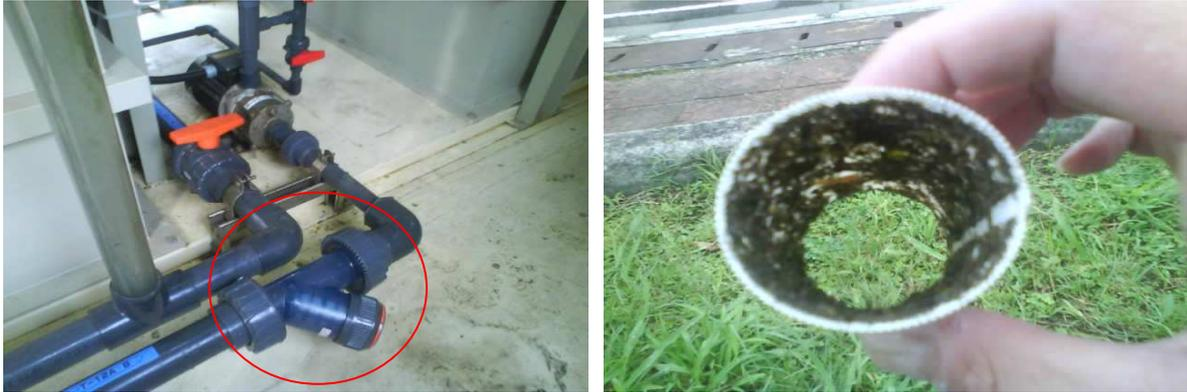
圖 24 Y 型過濾器及阻塞情形
