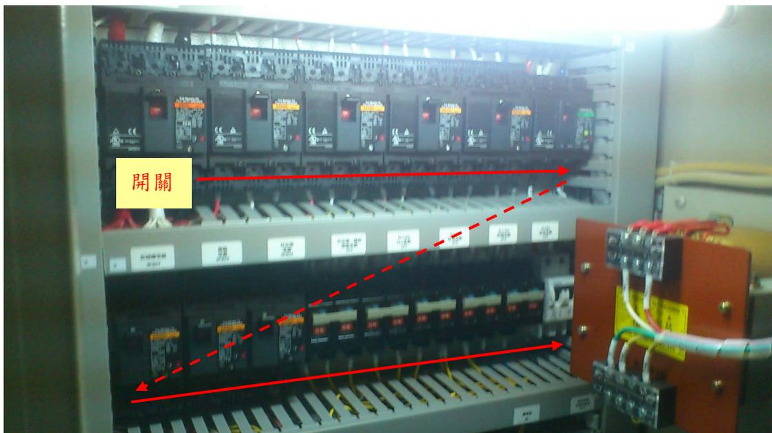
5. 切換主控盤 1 各泵浦及控制閥之開啟狀態(預設旋鈕左邊為【自動】、中間為【關閉】、右邊為【手動】，如下圖)
