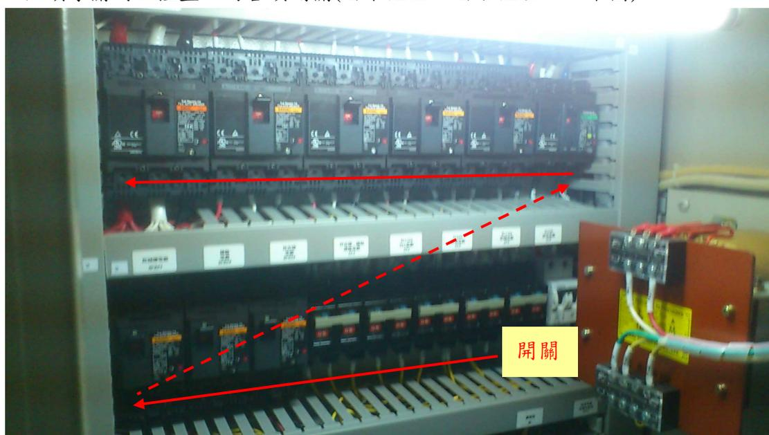
6. 打開電源及 PLC 主控盤 1(凝劑儲槽右邊，靠近控制室，如下圖)
