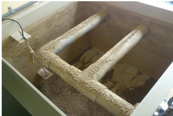
圖 26 快濾槽進水散水導管
