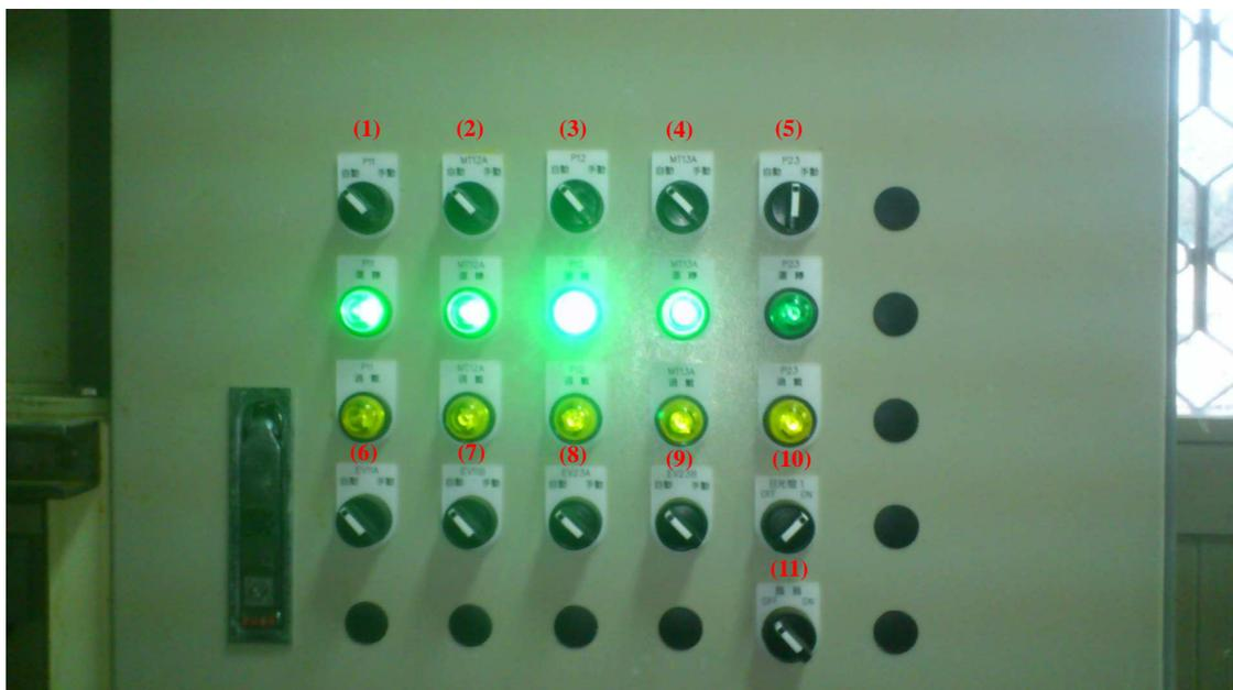
5. 切换主控盤 2 各泵浦及控制閥之開啟狀態(預設旋鈕左邊為【自動】、中間為【關閉】、右邊為【手動】，如下圖)
