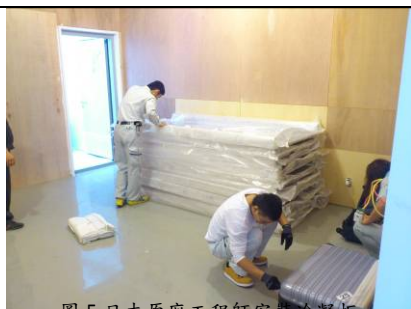
圖 5.日本原廠工程師安裝冷凝板
