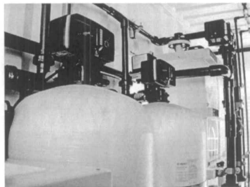
槽體單元安裝-3
