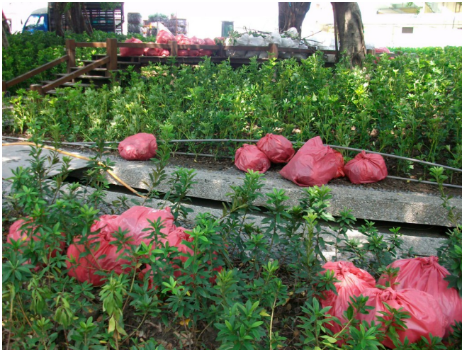
沿足球場外圍行走便可發現，處處皆有尚未完工的跡象。值得一提的是，工程原本預計於5月便可全面完工。（攝影／王雅涵）
