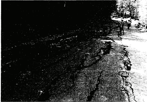
圖五 道路因填方介面滑動而龜裂
