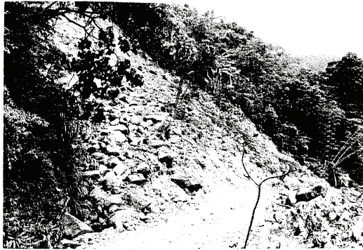
圖三 落石與表層崩落
