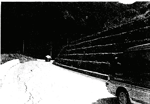
圖七 蛇籠式柔性擋土設施
