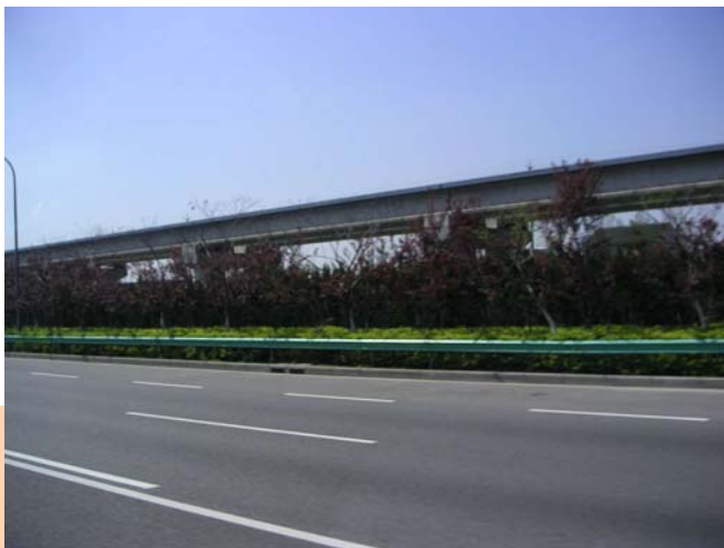
▲ 連接浦東機場的磁浮列車軌道(圖一)
