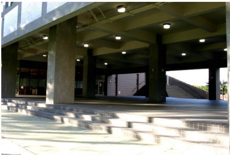
▲ 交映樓一樓通廊
